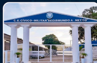
Construção de um muro no Colégio: R$ 190.000,00
